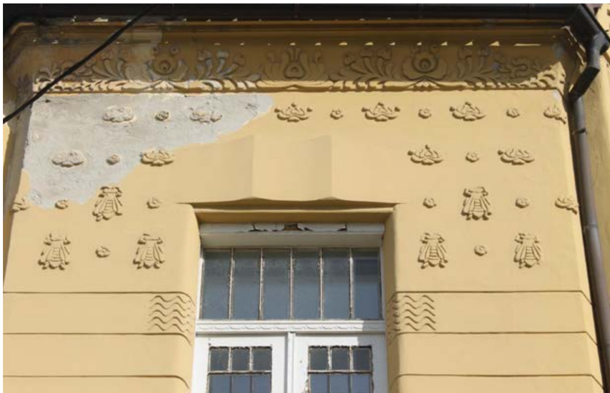
Pročelje nekdanje hranilnice južne Železne županije (danes Hranilnica prekmurskih dobrot) avtorja László Takátsa, ki je deloval tudi v Budimpešti - Foto: Tomaž Galič Az egykori Dél-vas megyei Takarékpénztár homlokzata (ma a Muravidéki finanságok kincsestára) a Budapesteni is dolgozó Takács László műve - Fotó: Tomaž Galič
